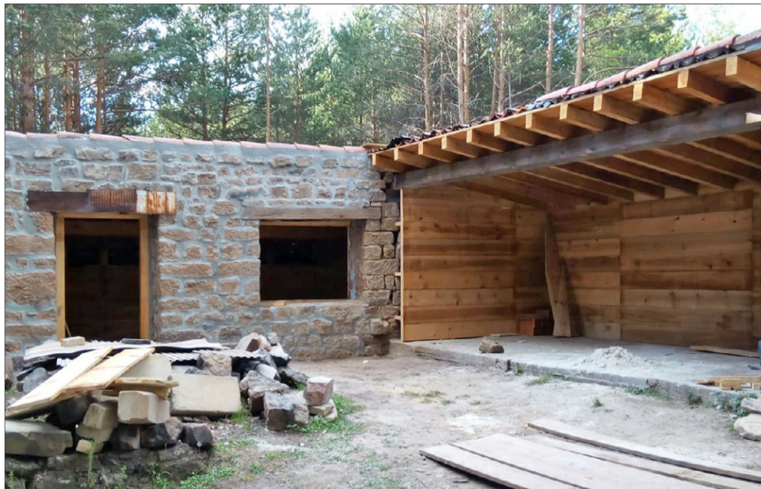
En el chozo de Cabezalero, las antiguas paredes de piedra se están entablado con pino. FOTOS: A.M.C.
